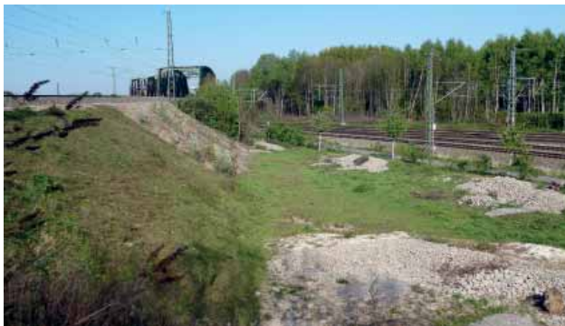
Abb. 49: Die Güterumgehungsbahn unterbricht die geplante Grünverbindung zwischen der Kleingartenanlage Am Dornwäldle und dem Otto-Dullenkopf-Park. An dieser Stelle fehlt eine Querungsmöglichkeit.
