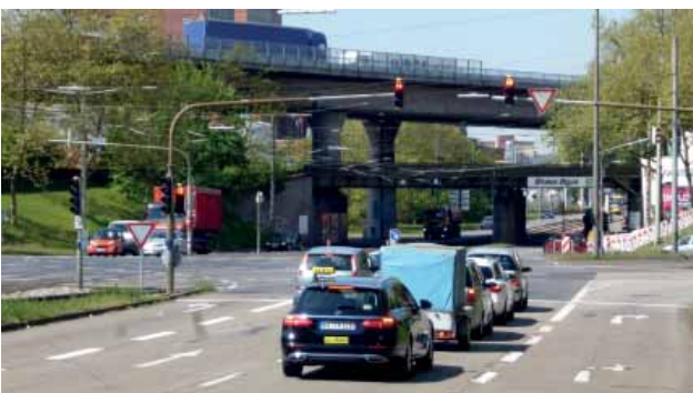
Abb. 32: Die Engstelle an der Honselstraße erschwert die Verknüpfung der Stadt mit dem Landschaftspark Rhein.
