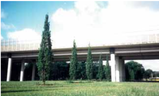
Abb. 129: Positives Beispiel für die Querung einer Auensituation in Krefeld: aufgeständerte Straßenführung mit fensterartigen Öffnungen. Das Bepflanzungskonzept mit den säulenförmigen Bäumen nimmt die Brückenkonstruktion mit ihren schlanken Pfeilern thematisch auf. Lärmschutzwände zum Schutz des Naherholungsgebietes.
