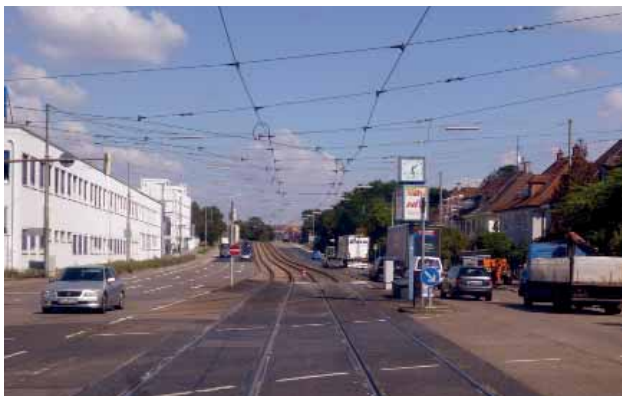
Abb. 83: Stadteinfahrt Eckenerstraße: hier fehlen Bäume und Rasengleise.
