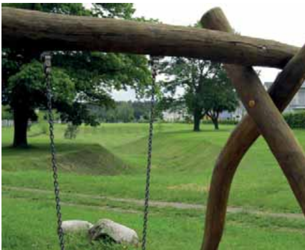
Abb. 127: Tief eingeschnittene Versickerungsmulde in der Konversion Blankenlocher Weg, die an dieser Stelle gut in den Freiraum eingebunden werden könnte. Das im Hintergrund erkennbare Rückhaltebecken könnte flachere Böschungen und begleitende Strukturelemente vertragen. Das Erscheinungsbild wäre dann gefälliger und weniger wasserbautechnisch geprägt.
