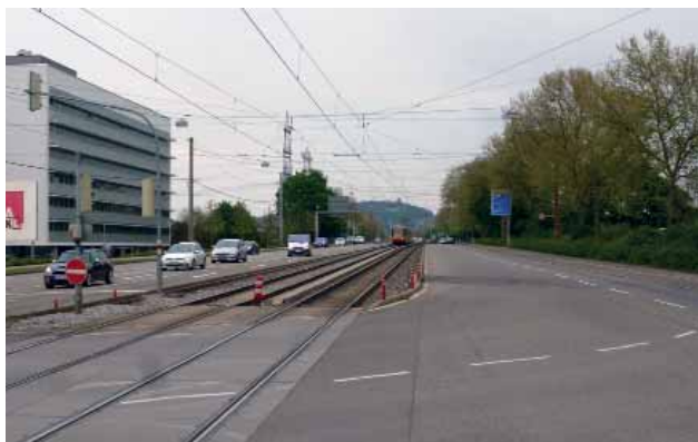
Abb. 90: Die Durlacher Allee auf Höhe des Weinweges: Bäume auf der Nordseite und ein grünes Band in der Straßenmitte würden diesem Teil der Stadteinfahrt ein freundlicheres Erscheinungsbild geben.
