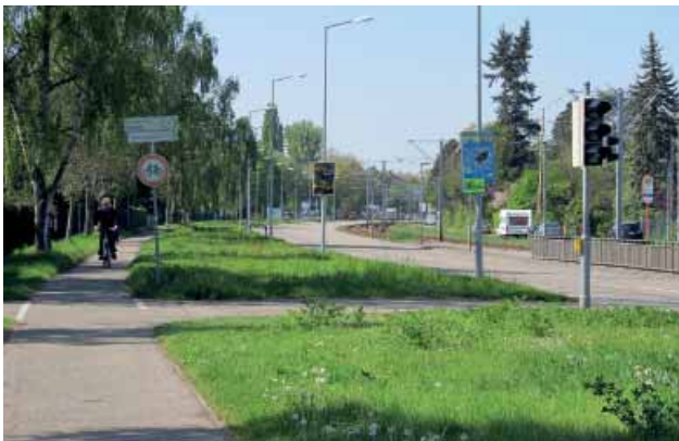
Abb. 92: Die Haid-und-Neu-Straße auf Höhe des Technologieparks, der künftig die rechte Straßenseite stärker als bauliche Kante in Verbindung mit einer Baumreihe prägen soll.
