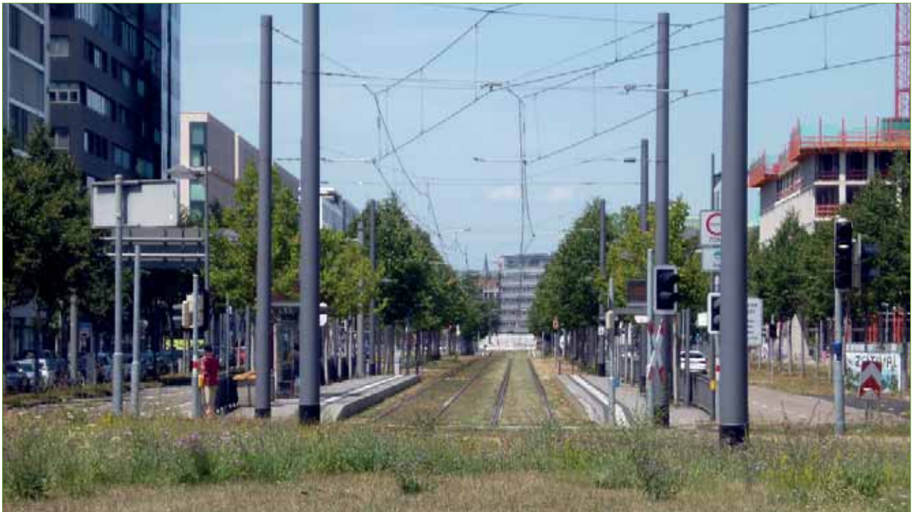
Abb. 79: Die Ludwig-Erhardt-Allee besticht durch den gut proportionierten Straßenquerschnitt und durch die geradlinig verlaufenden Lindenreihen. Die Abbiegespuren sind optimal integriert, ohne dass die Baumreihen unterbrochen werden mussten.
