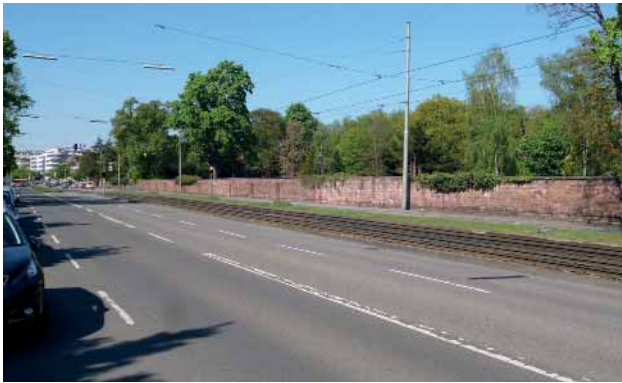
Abb. 122: Stadträumlich unbefriedigende Kante entlang des Hauptfriedhofs: hier fehlen Bäume, die das breite, gegenüber dem Friedhof unmaßstäblichen Band der Haid-und-Neu-Straße gliedern.
