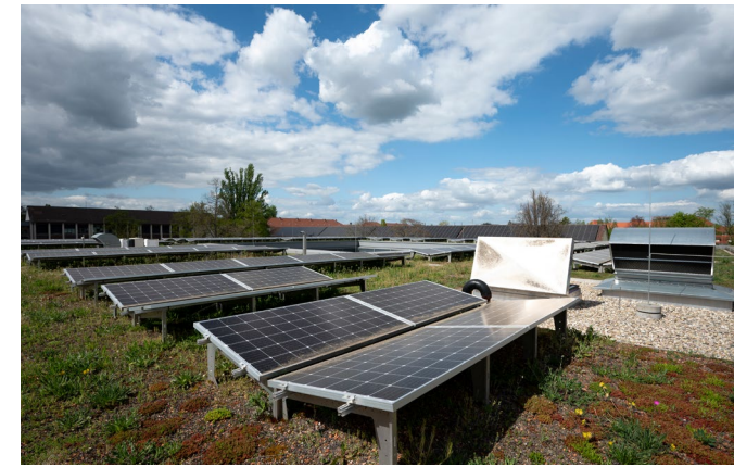
Dach der Drais-Gemeinschaftsschule
