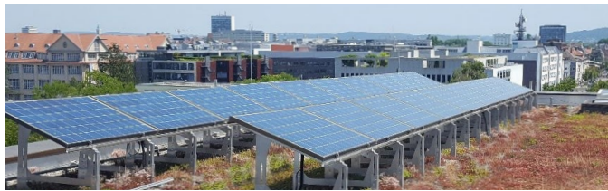
Dach der Fachschule für Wirtschaft
