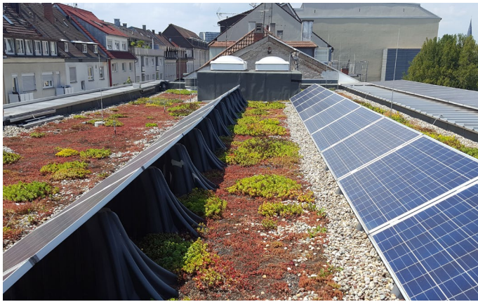
Dach des Fichte Gymnasiums
