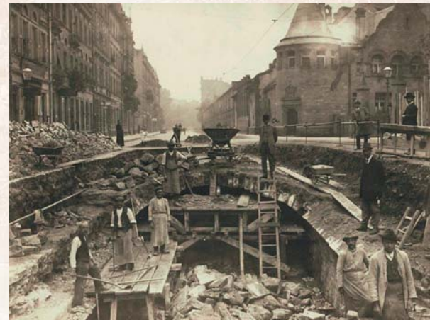
Construction site in Kapellenstraße, 1919
