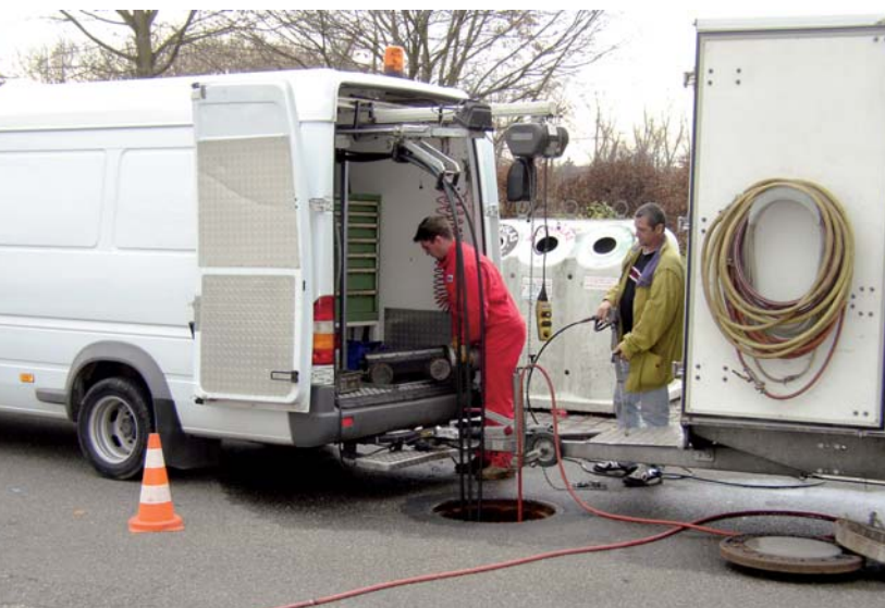
Utilisation d'un véhicule d'assainissement du canal
