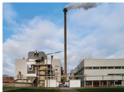
Incinérateur de la boue d'épuration
