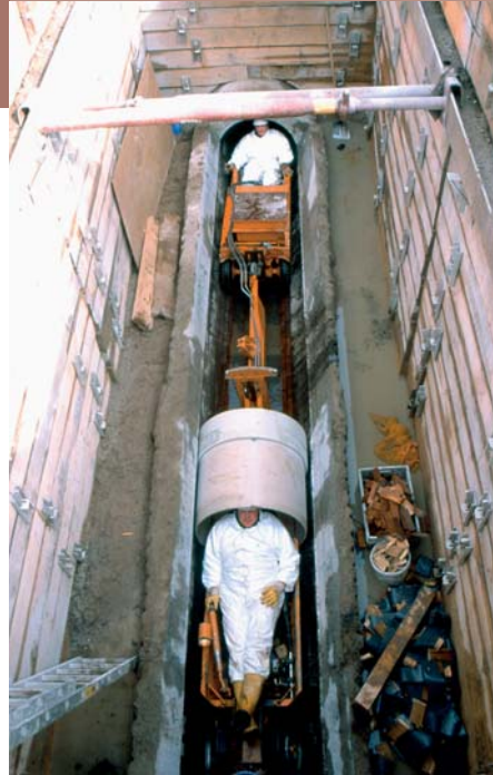
Fosse d'entrée pour le procédé de chemisage des tubes
