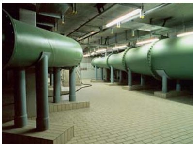
Dispositif de pompage de la boue
