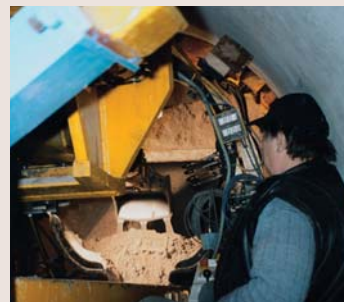
Front de taille en cours d'exploitation
