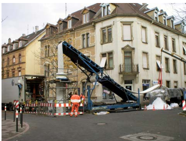
Insertion d'un tuyau en plastique
