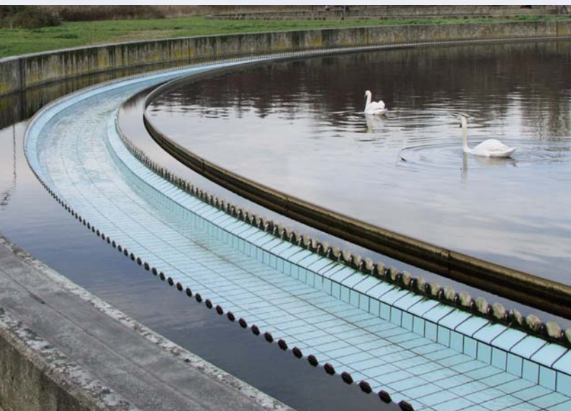
Écoulement des bassins de décantation secondaire
