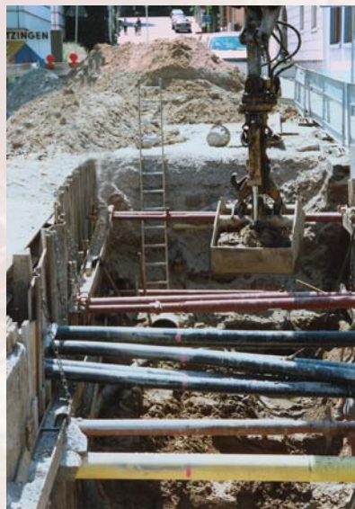
Les lignes d'alimentation compliquent le travail
