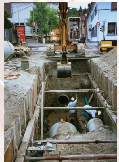
Remplacement de canaux à ciel ouvert
