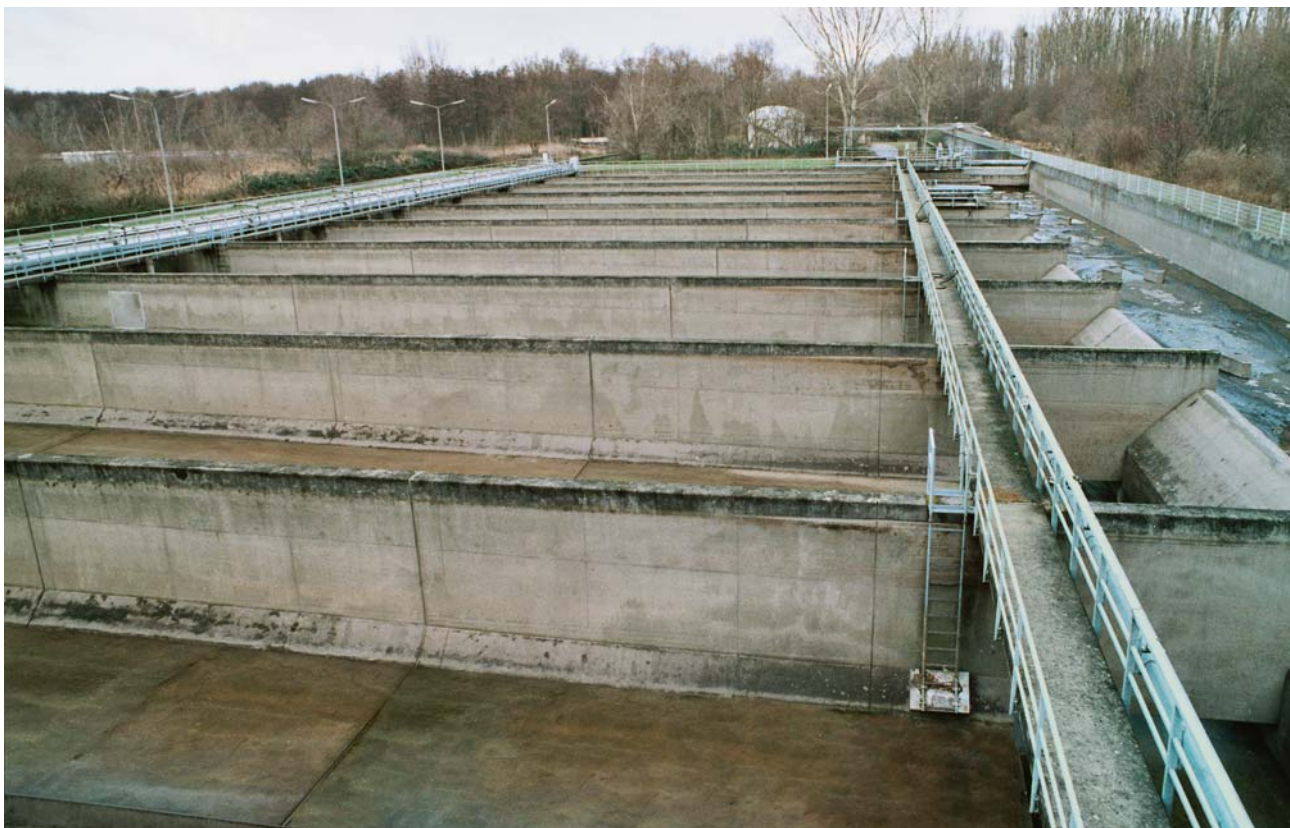
Bassins déversoir d'orages dans la station d'épuration dont la capacité est de 18 000 m 3
