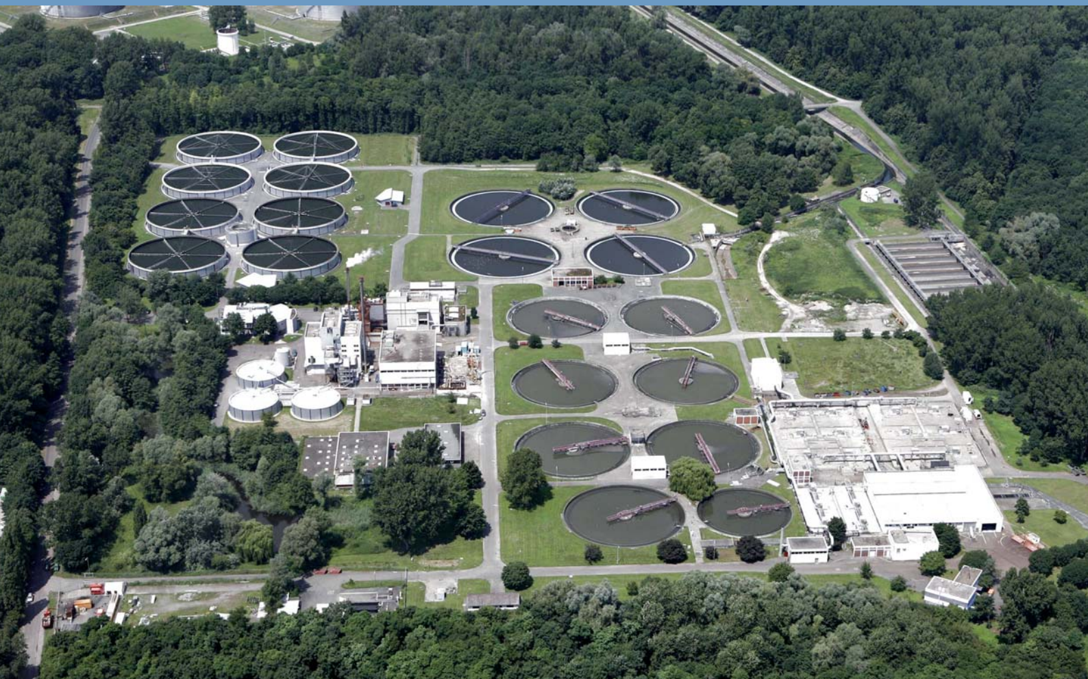
Station d'épuration de Karlsruhe en 2009
