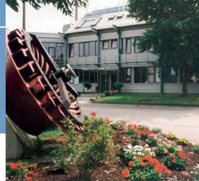
Bâtiment administratif de la station d'épuration
