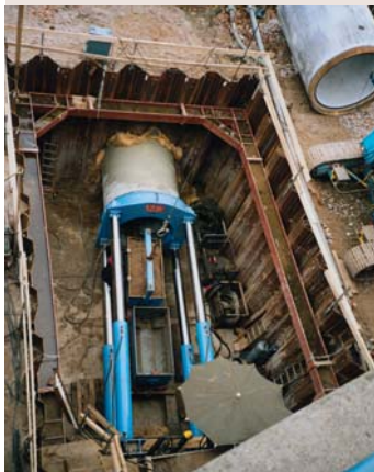
Puits de descente avec des dispositifs hydrauliques
