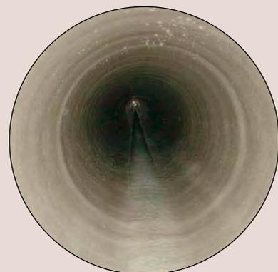
*Nach der Sanierung: Mit glasfaserverstärktem Kunststoff ausgekleideter Kanal*
