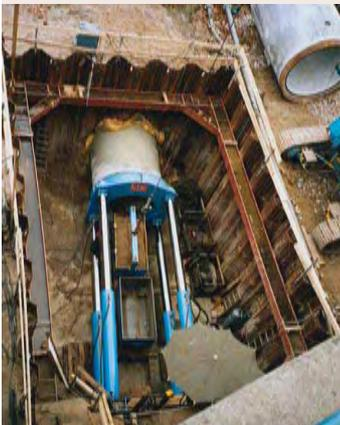
Vorpressgrube mit den Hydraulikpressen
