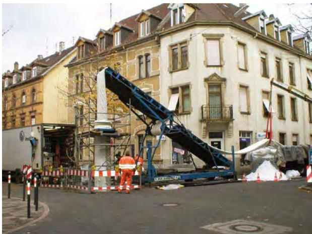
*Einbringen des Kunststoffschlauches*
