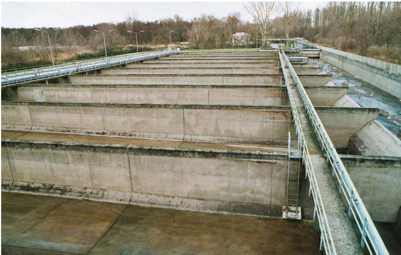
*Regenüberlaufbecken im Klärwerk mit einer Aufnahmekapazität von 18 000 Kubikmetern.*
