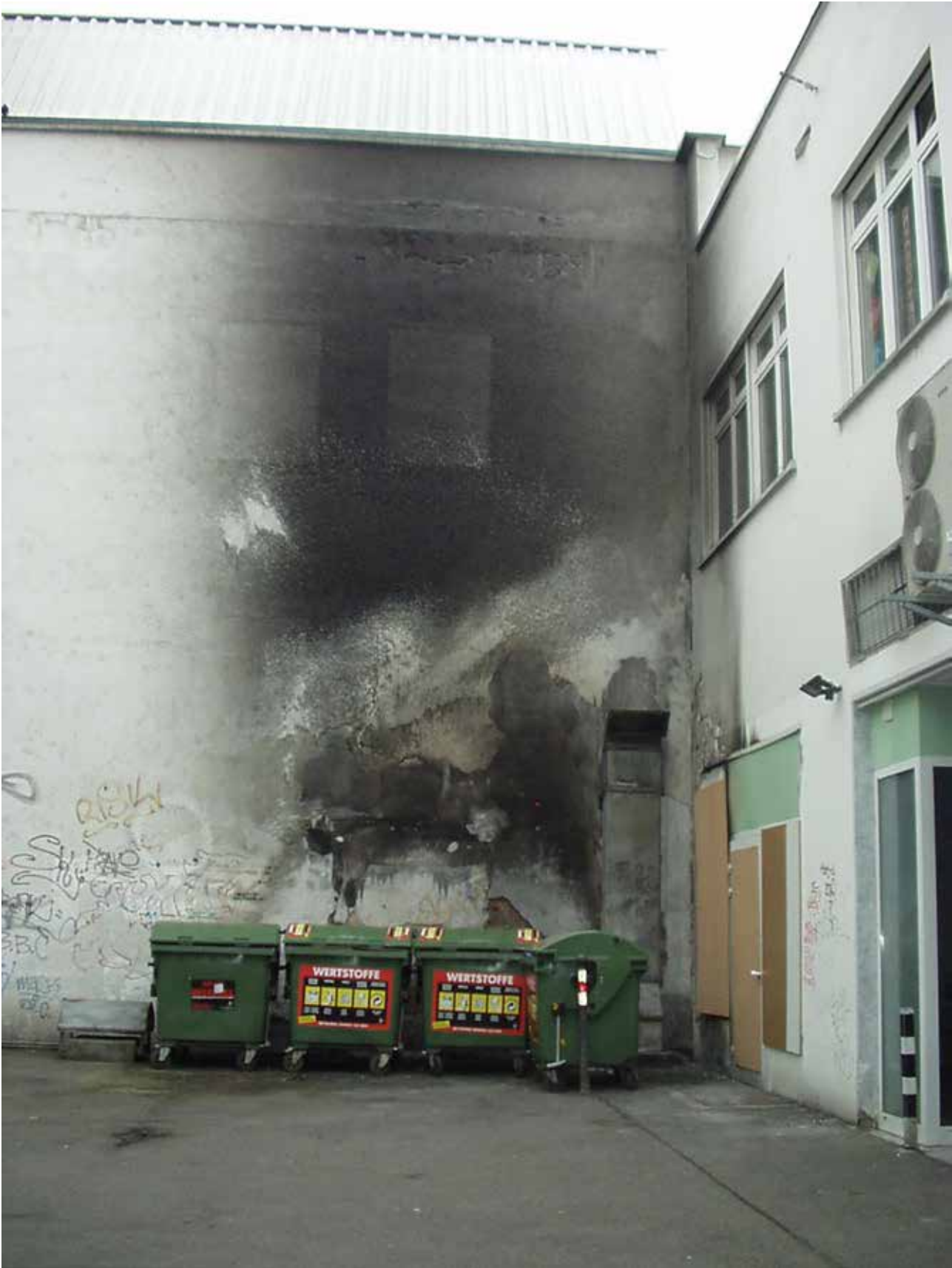
Der Waldhof vor der Sanierung
