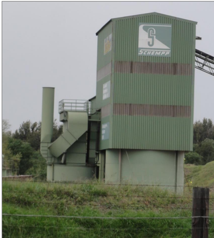
Abb. 5.2: Ableitbedingungen des Luftsichters, Blick aus östlicher Richtung
