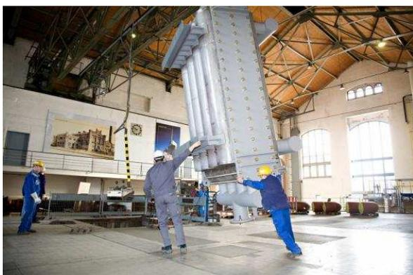
*Dicker Brocken: Einbau der Plattenwärmetauscher in der Heizzentrale im HKW West im Frühjahr 2010*
