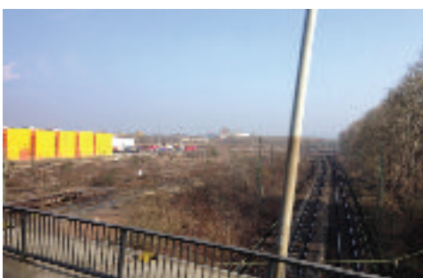
Gleisanlagen im Zwischenraum
